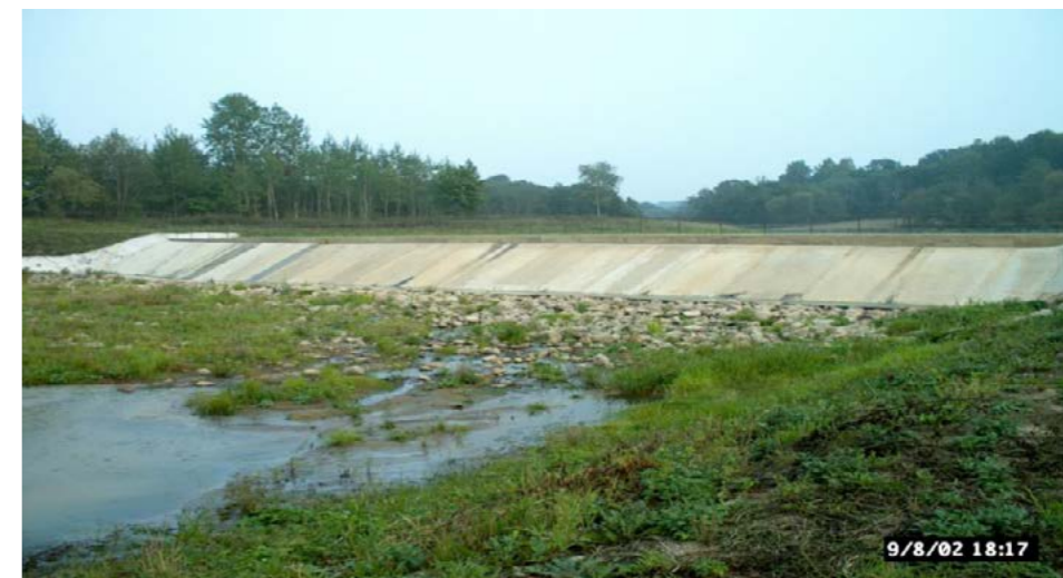
☒ Vietoje buvusio malūno „atstatyta“ Valtūnų hidroelektrinės užtvanka ant Siesarties
